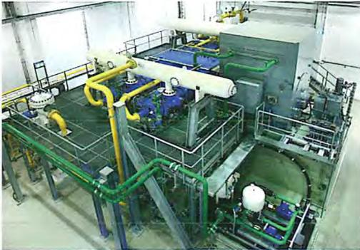
*Kolbenverdichter für Erdgasspeicher von BORSIG ZM.*
