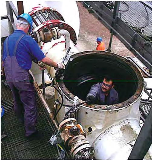
*Reparatur eines Kugelhahns.*
